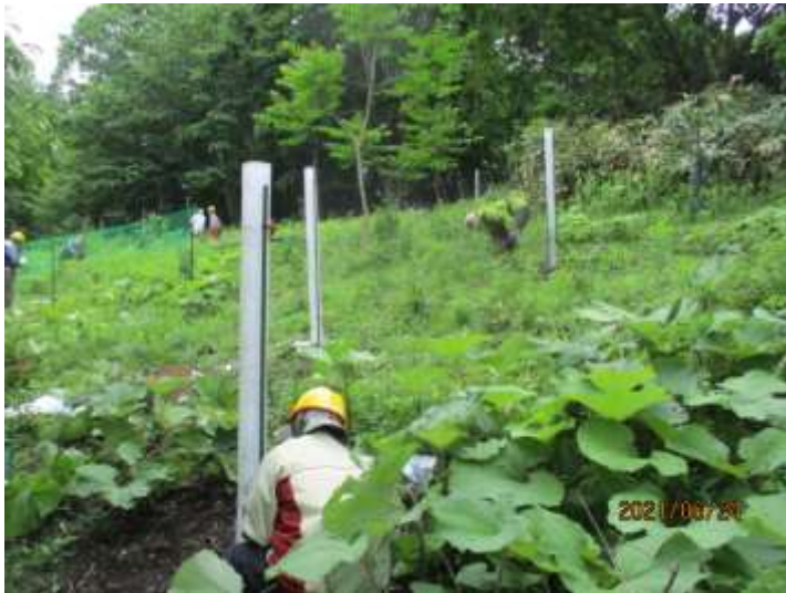
ツリーシェルターの設置
