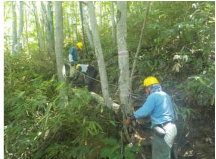
作業道整備（階段補修）
