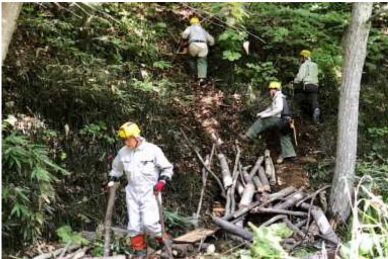
作業道整備（階段設置）
