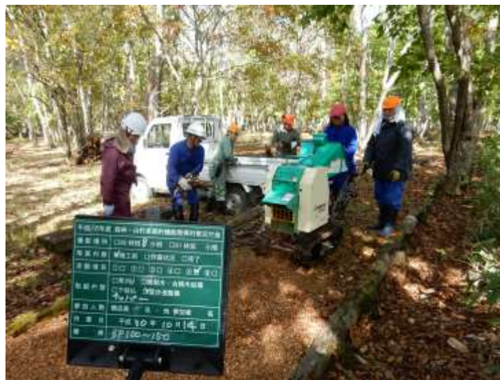
散乱している枝をチップパーで処理
